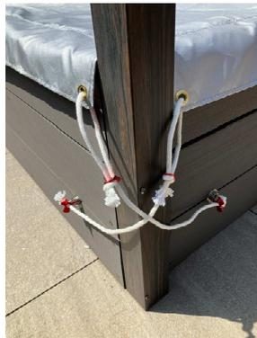
②デッキペグを柱をはさんでクロスさせます。デッキペグを下から一枚目と二枚目のデッキのすき間に差し込みます。バネになっていますが奥まで差し込んで90度ひねってゆっくり離します。この時点ではまだロープは絞らないでおきます。
