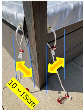
①シートをバランス良く置きます。柱の脇のデッキの内側にはアルミの角材が入っているので避けるようにします。柱から10~15cmのところを狙って差し込みます。
